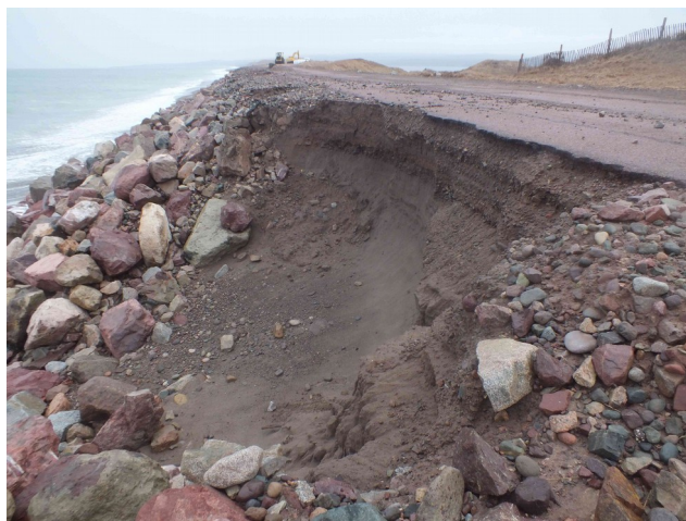
Légère évolution de l'érosion de l'effondrement près de la plateforme centrale côté amont
